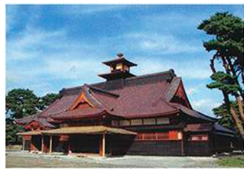
4年間の工期をかけて、往時の建築を忠実に再現した箱館奉行所(2010年完成)
