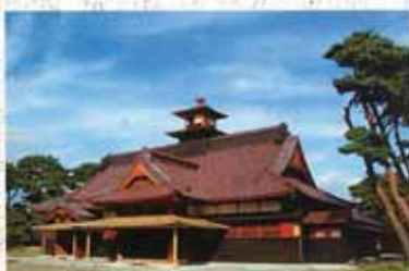
4年間の工期をかけて、往時の建築を忠実に再現した箱館奉行所(2010年完成)
